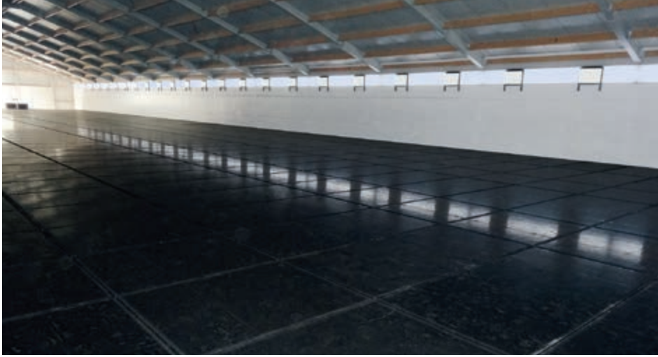
Так виглядає проміжна стеля із пластикових панелей – до того як систему встановлено на другий ярус
