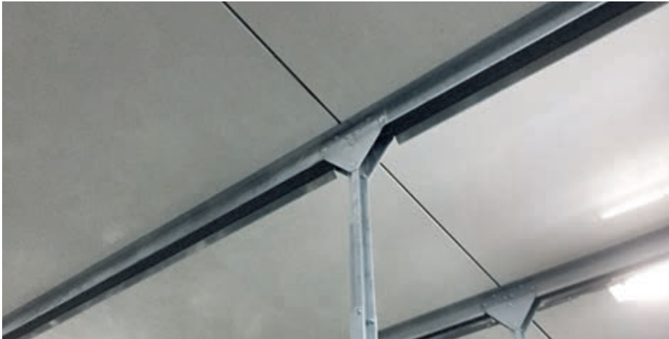
Гладка біла поверхня пластикових панелей дозволяє свіжому повітрю вільно і без перешкод рухатись по будівлі. Також вони збільшують рівень освітлення на нижньому ярусі
